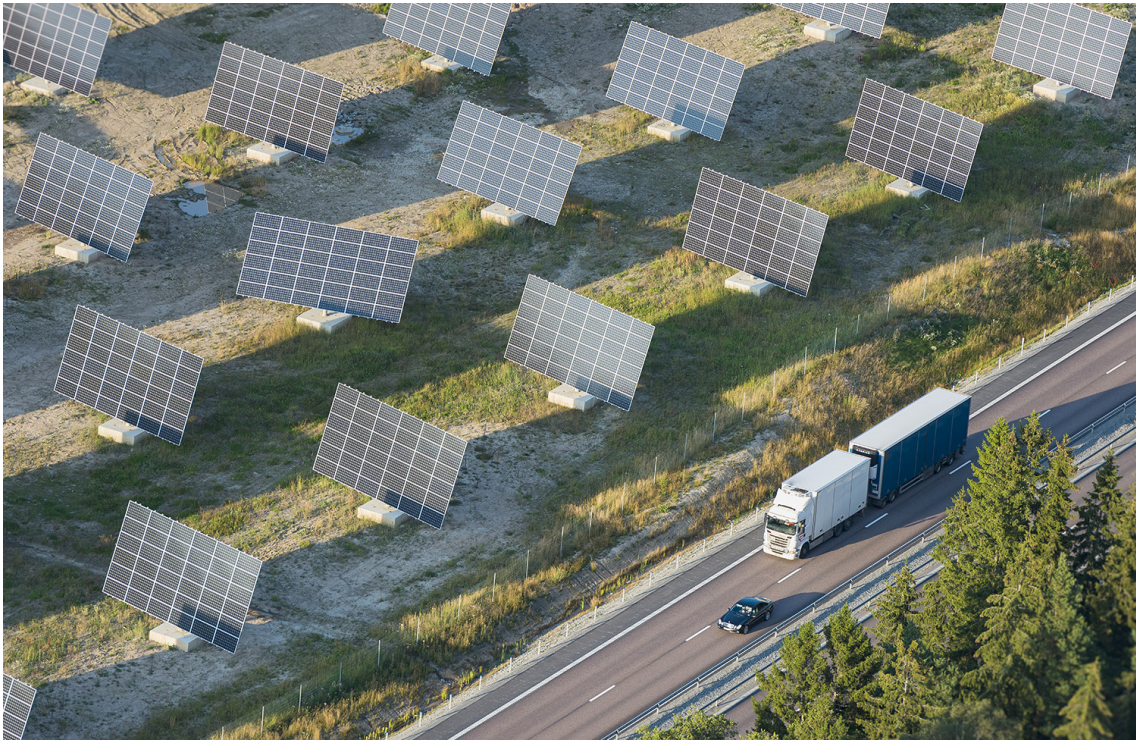
Solar panels in Västerås Sweden.
