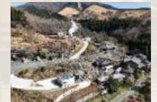
Sansui power plant (Kumamoto, Oguni)
