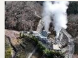
Shika power plant (Kumamoto, Oguni)
