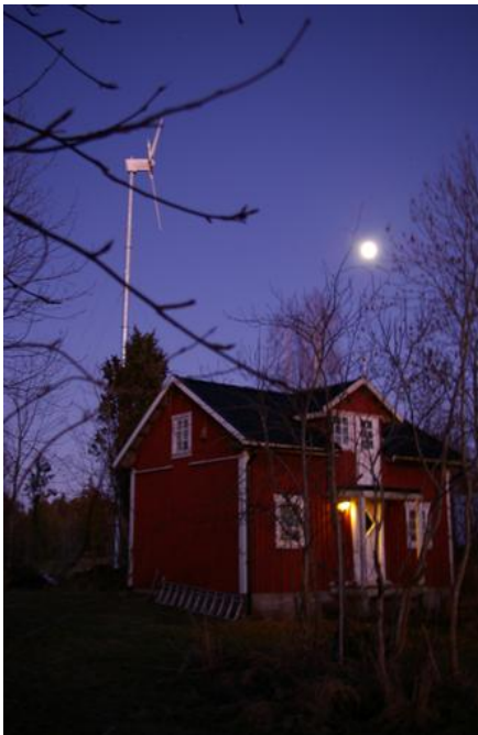
Figur 5: Vindkraftverk installerat på villatomt i södra Sverige. Installerad effekt 5,5 kW. (Källa: www.winden.se )
