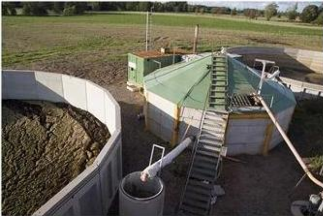
Figur 8: Gårdsgasanläggning på Stora Svenstorp utanför Götene. Gödselbrunnen har blivit röt-kammare. (Källa: Götene Gård)
